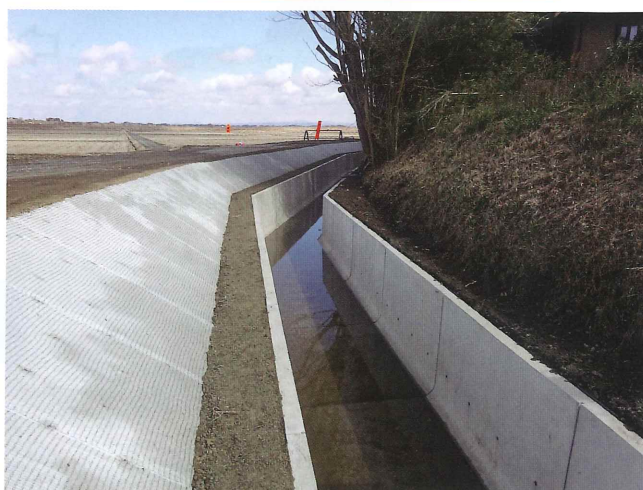
蕪栗沼地区宝江水路施工状況
