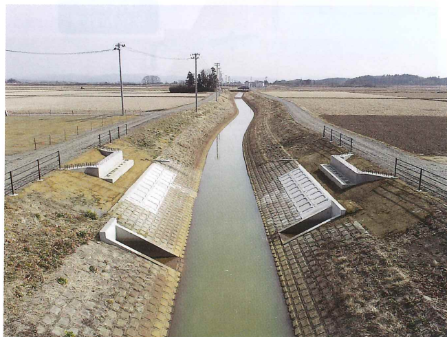
鹿飼沼地区橋梁下部工事完成写真
